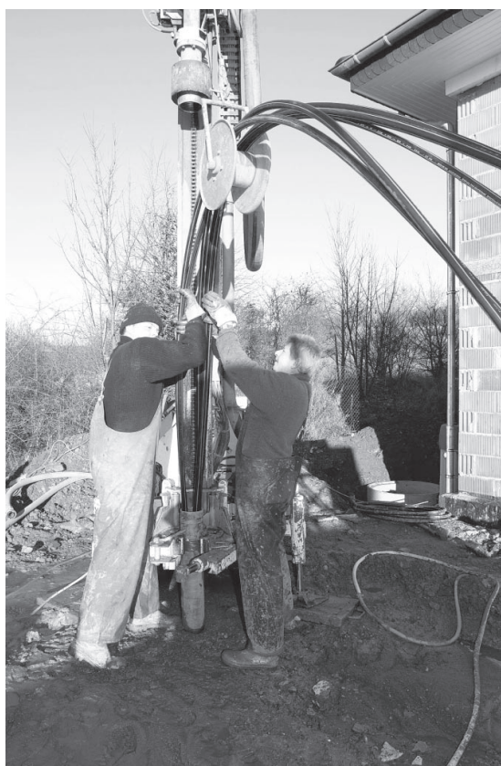
Rys. 2.8. Wprowadzanie sondy gruntowej do odwiertu
