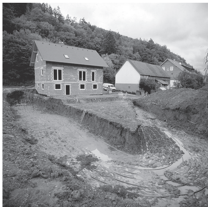
Rys. 2.5. Wykonanie dolnego źródła- kolektora gruntowego
