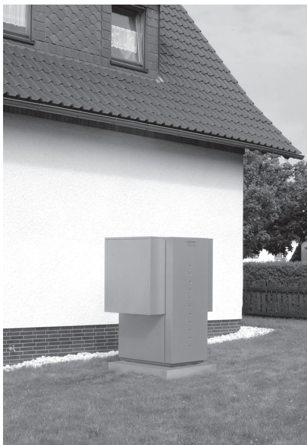
Rys. 1.2. Pompa ciepła powietrze/woda Vitocal 350, wariant- jednostka zewnętrzna
