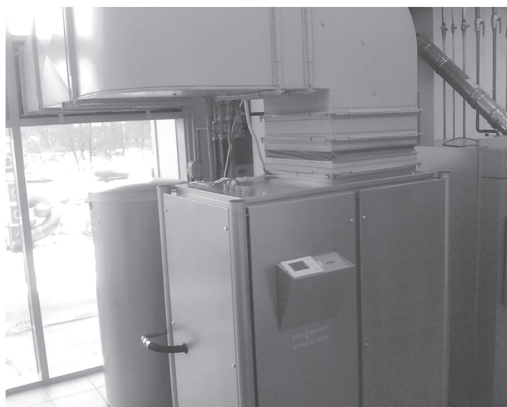
Rys. 2.9. Pompa ciepła typu powietrze/woda Vitocal 300 firmy Viessmann.
