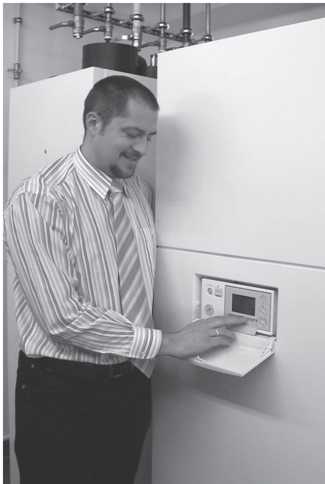
Rys. 2.2. Kompaktowa centrala grzewcza Vitocal 343 (na zdjęciu – Autor)
