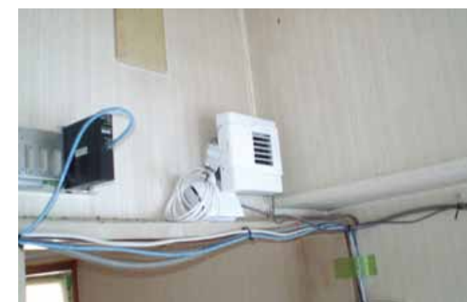
Kratka wyciągowa BXS w kuchni
