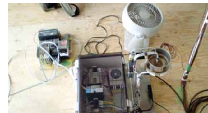
Emiterzy wody i ciepła wykorzystywane w salonie/kuchni
