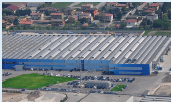
Zakłady produkcyjne Blue Box o powierzchni blisko 40 000 m 2 , zlokalizowane we Włoszech w miejscowości Cantarana di Cona pod Wenecją.
