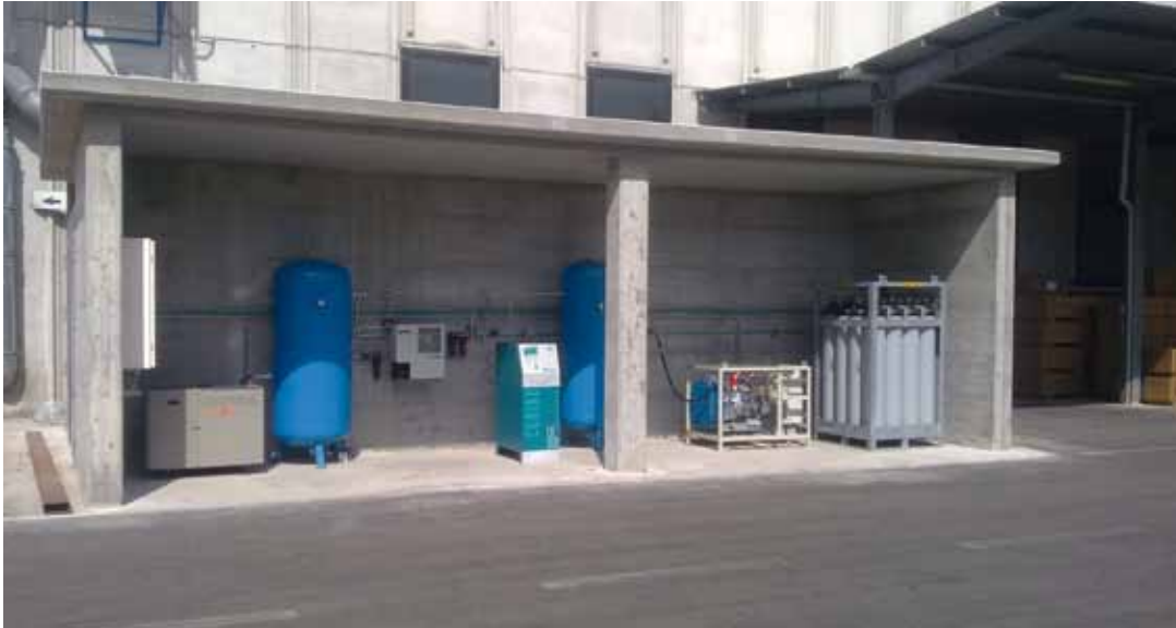
Komora testowa wyposażona jest w wysokociśnieniową sprężarkę, która dostarcza suche powietrze.
