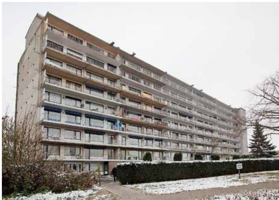
Po raz pierwszy w Belgii budynek mieszkalny - apartamentowiec Zilverberg - jest podgrzewany przez nadwyżkę energii ze spalarni miejskich odpadów.
