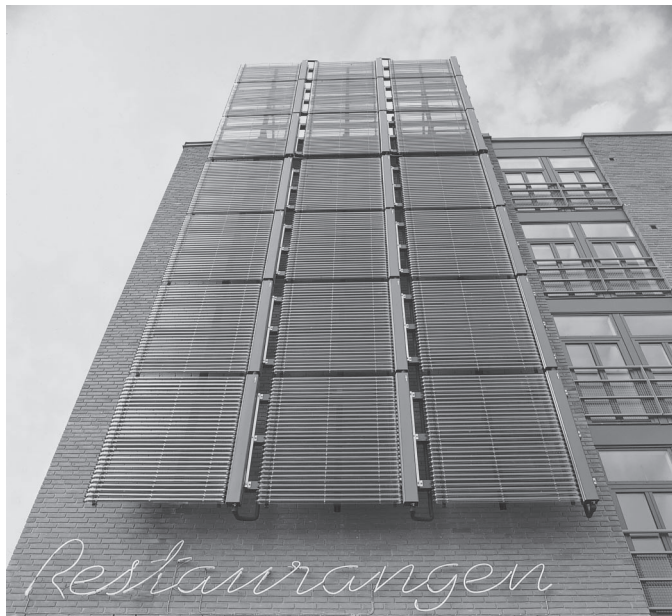
Rys. 3.4. Zabudowa kolektorów Vitosol 200 na elewacji budynku („City of Tomorrow”, Malmö, Szwecja).
