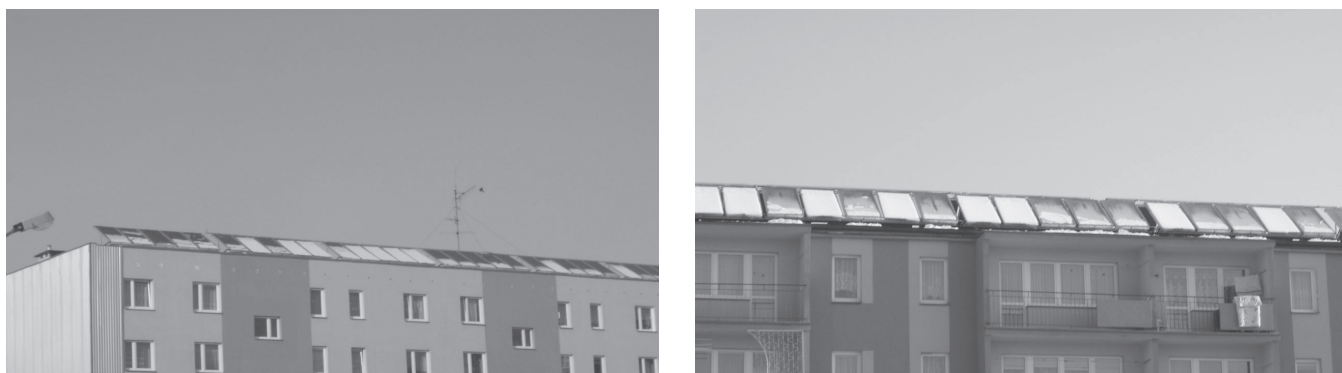
Rys. 2.11. Przykłady pracy dużych instalacji z harfowymi kolektorami słonecznymi. Polska 2005 r.
