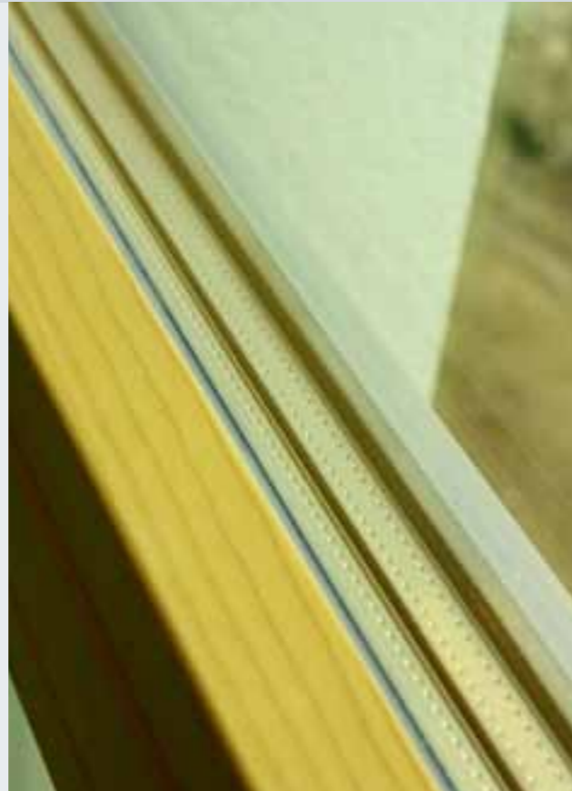
Przykład okna pasywnego, widoczna ramka dystansowa z potrójnym przeszkleniem, hala sportowa w Słomnikach
