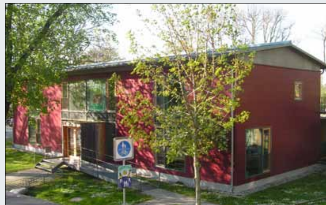
Przedszkole w standardzie budynku pasywnego, Lindau, Niemcy
