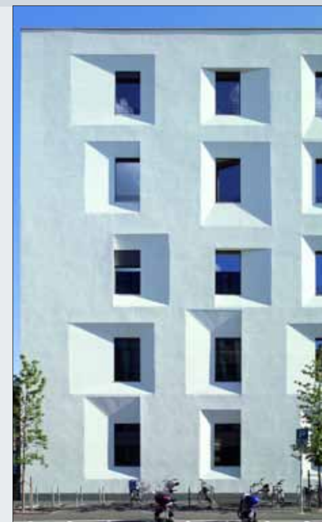
Renowacja starego budynku poczty w miejscowości Bolzano, Włochy
