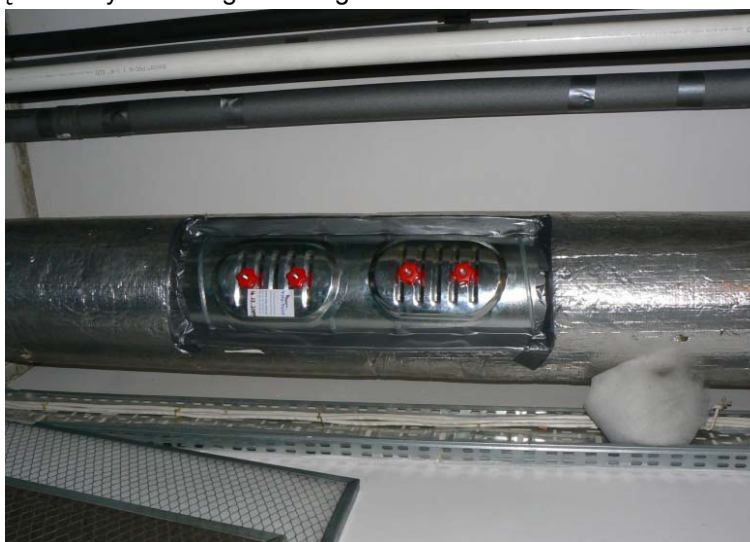
Rys. Klapy rewizyjne firmy ALNOR zamontowane podczas czyszczenia instalacji wentylacyjnej przez Vita-Vent
