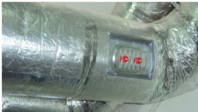
Rys. Przykład zamontowania klapy rewizyjnej IPR
