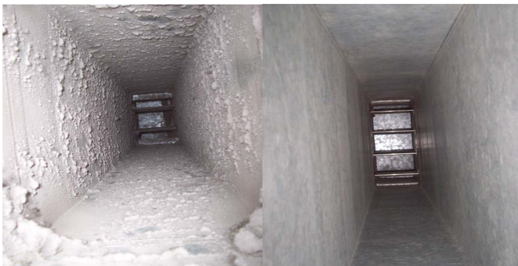
Rys. Kanały wentylacyjne przed oraz po czyszczeniu
