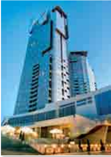
Lokalizacja: Gdynia – Polska Obiekt: Sea Towers – kompleks apartamentowo-biurowy Aplikacja: Zawory AB-QM grzanie/chłodzenie
