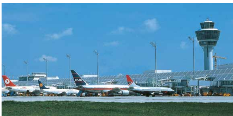
Munich Airport, Niemcy
