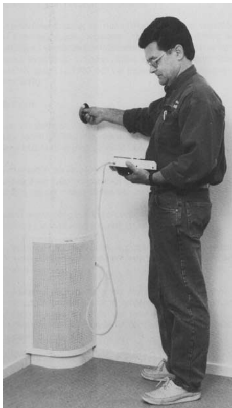
Zdjęcie 1. Regulacja nawiewnika waporowego.
