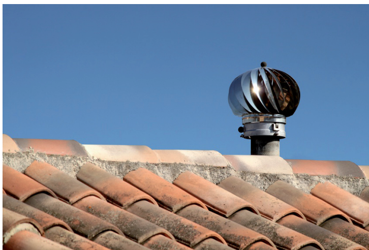
Rys. nr 7 Nasada kominowa wspomagająca działanie wentylacji
